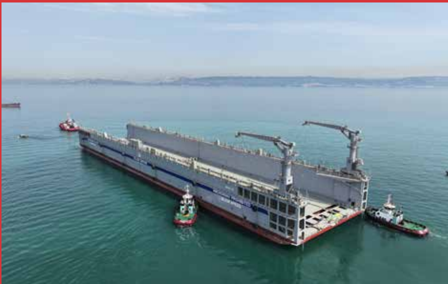
NB22 BLRT DOCK 10.000 TLC - 180 x 30 m
